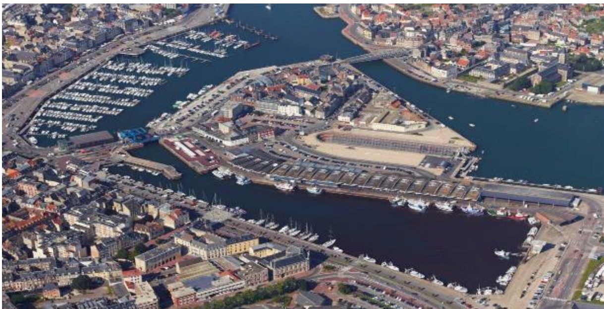
Slika 10 Ribarska luka Dieppe kanalskog oblika
