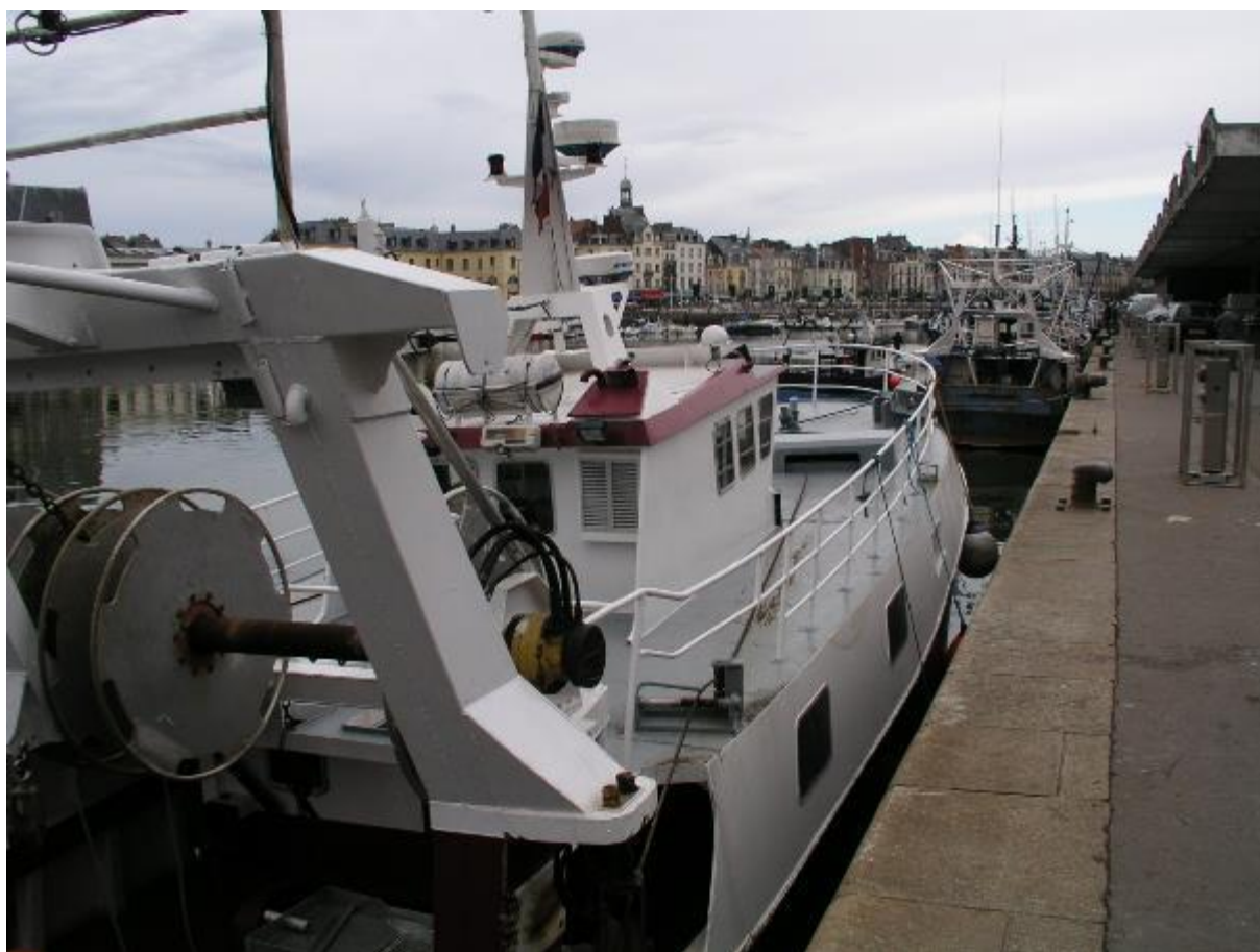
Slika 14 Iskrcajna obala s priključcima za vodu i električnu energiju
