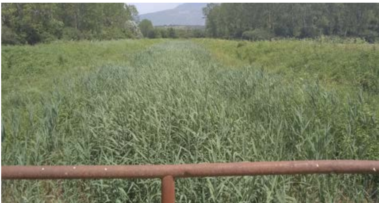
Slika 3.2.9./6. Obuhvatni kanal Kloštar (Foto: A. Orlović)
