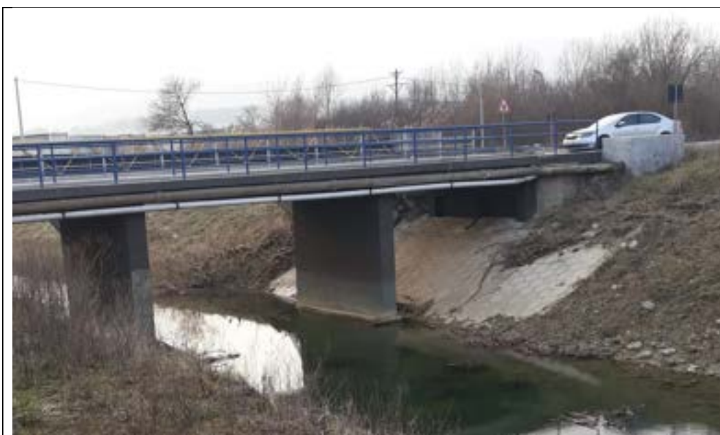
Slika 1.3.8/2.: Prikaz postojećeg mosta preko rijeke Raše na LC
