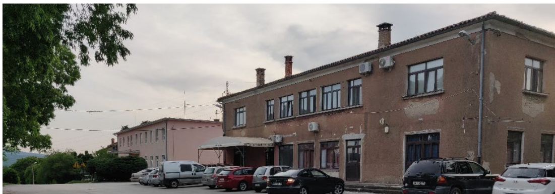
Slika 141 – Zgrada društvenog doma u Purgariji Čepić (Autor: 3E PROJEKTI d.o.o.)
