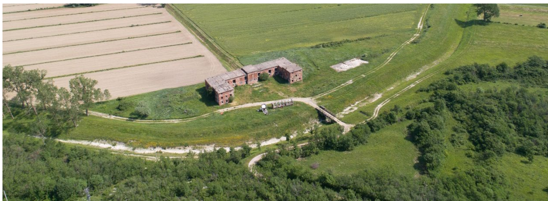
Slika 113 - Napušteni gospodarski objekti s pripadajućim otvornim prostorom u Čepič polju (Autori: 3E PROJEKTI d.o.o. i Andlar)
