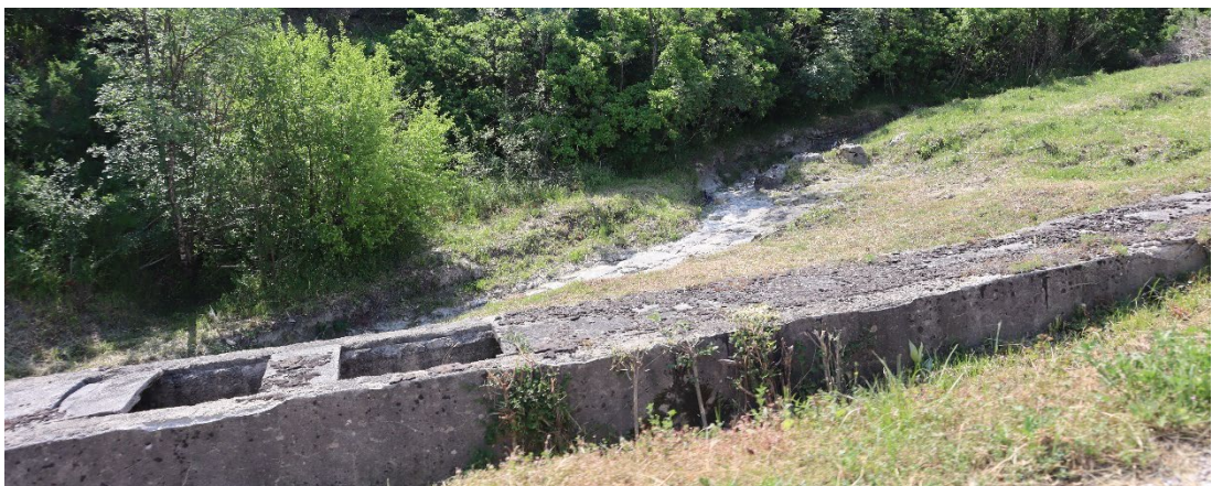
Slika 24 Bujični vodotoci Učke sa strukturama (Autor: 3E PROJEKTI d.o.o.)
