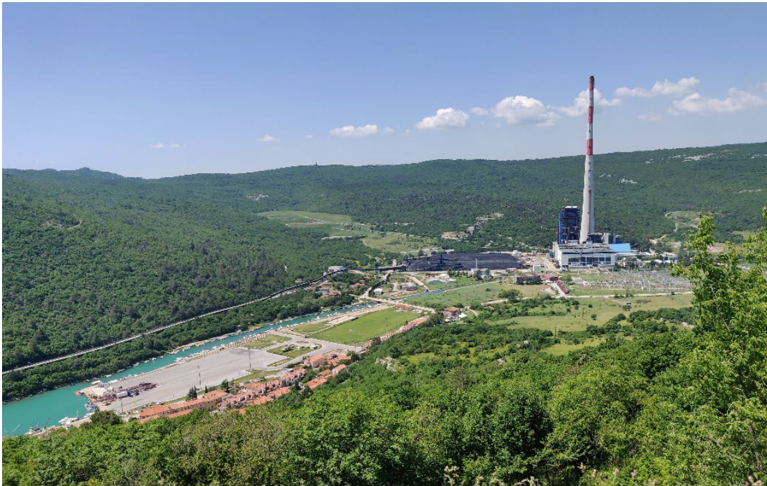
Slika 151 – Pogled na naselje Plomin Luka i TE Plomin (Autor: 3E PROJEKTI d.o.o.)
