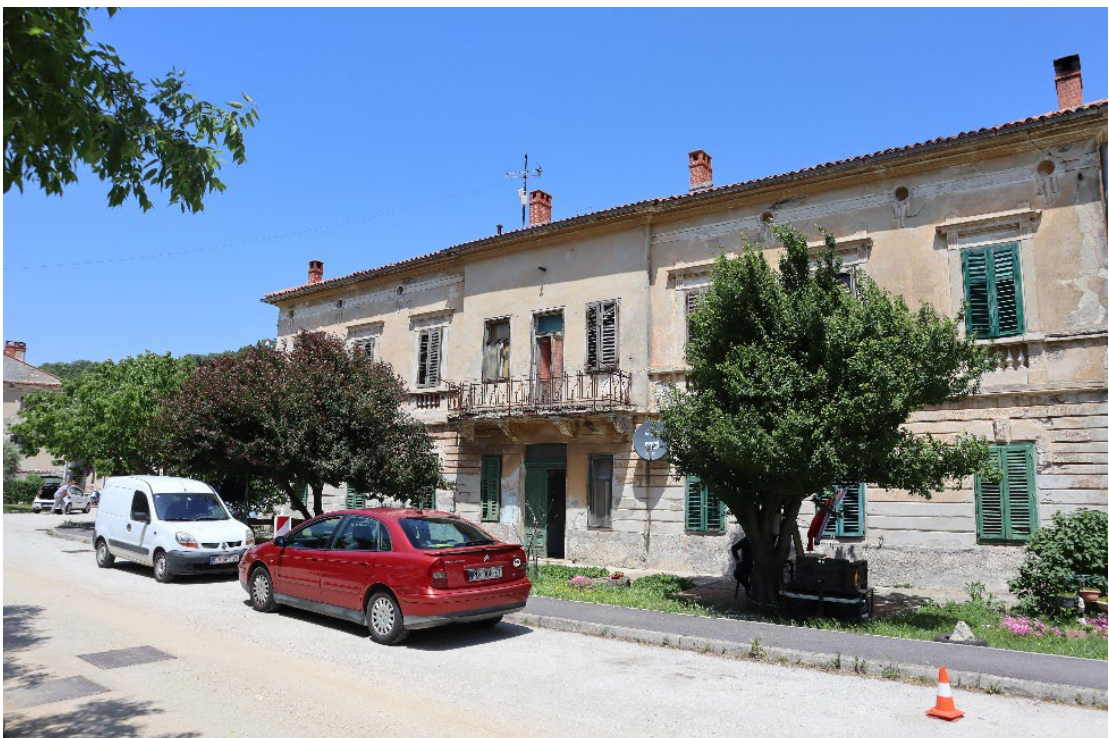
Slika 140 – Zgrada bivše lučke kapetanije u Plomin Luci (Autor: 3E PROJEKTI d.o.o.)
