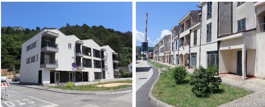
Slika 61 - Otvoreni prostori oko višestambenih objekata u Plomin Luci (Autor: 3 E PROJEKTI d.o.o.)
