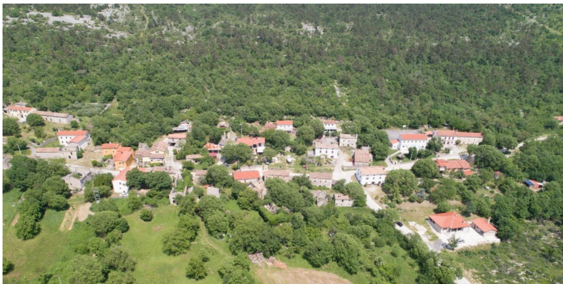
Slika 72 - Pogled na okućnice naselja Šušnjevića (Autori: 3E PROJEKTI d.o.o. i Andlar)
