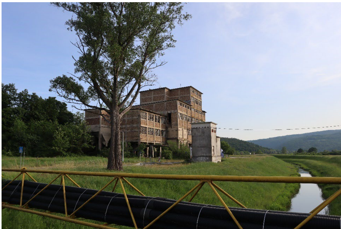
Slika 126 – Zgrada nekadašnje separacije ugljena u Potpičnu (Autor: 3E PROJEKTI d.o.o.)
