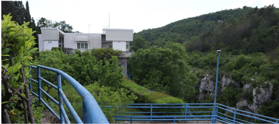
Slika 109 - Hidroelektrana Letaj (Autor: 3E PROJEKTI d.o.o.)
