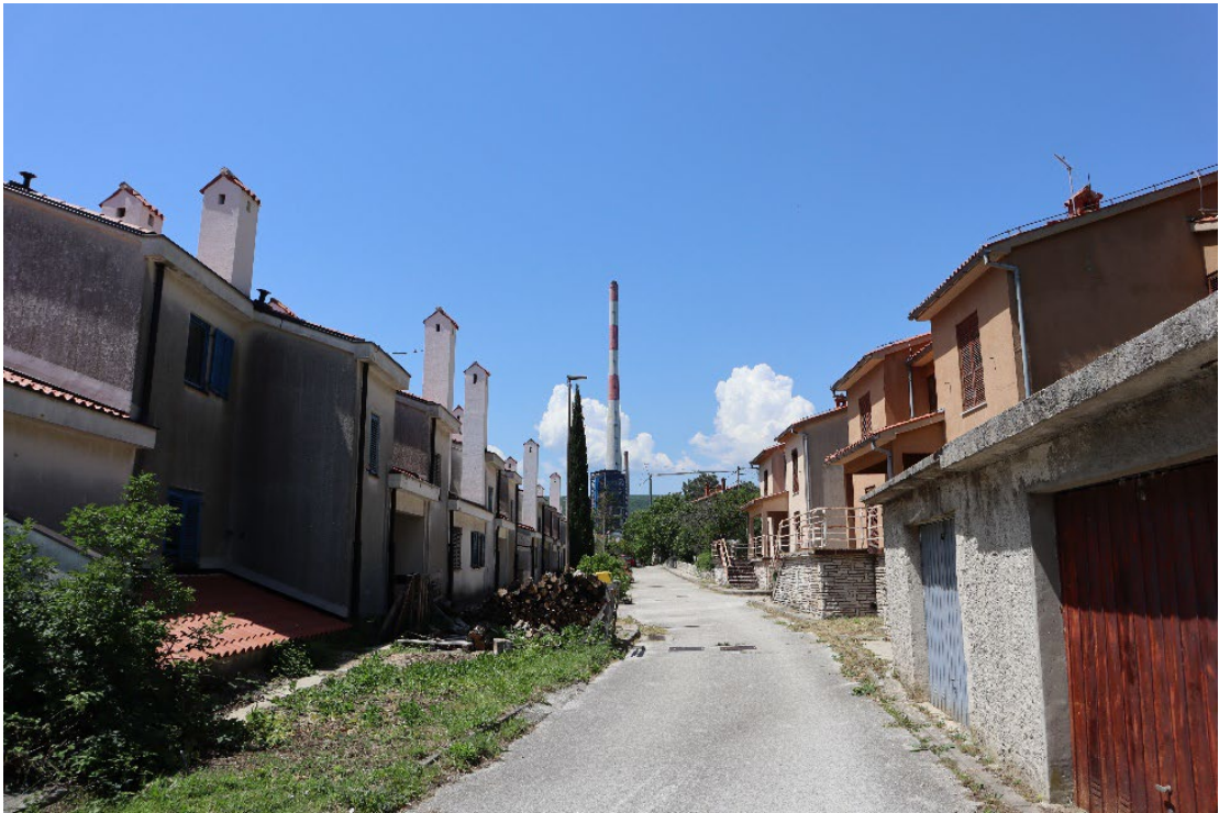
Slika 139 – Stambene zgrade HEP-a u Plomin Luci – stražnja pročelja (Autor: 3E PROJEKTI d.o.o.)
