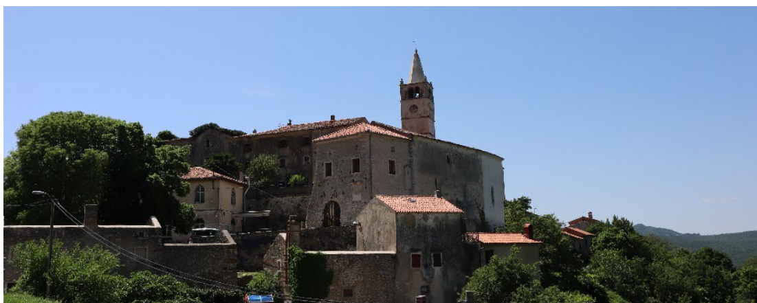
Slika 142 – Pogled na stari grad Plomin (Autor: 3E PROJEKTI d.o.o.)
