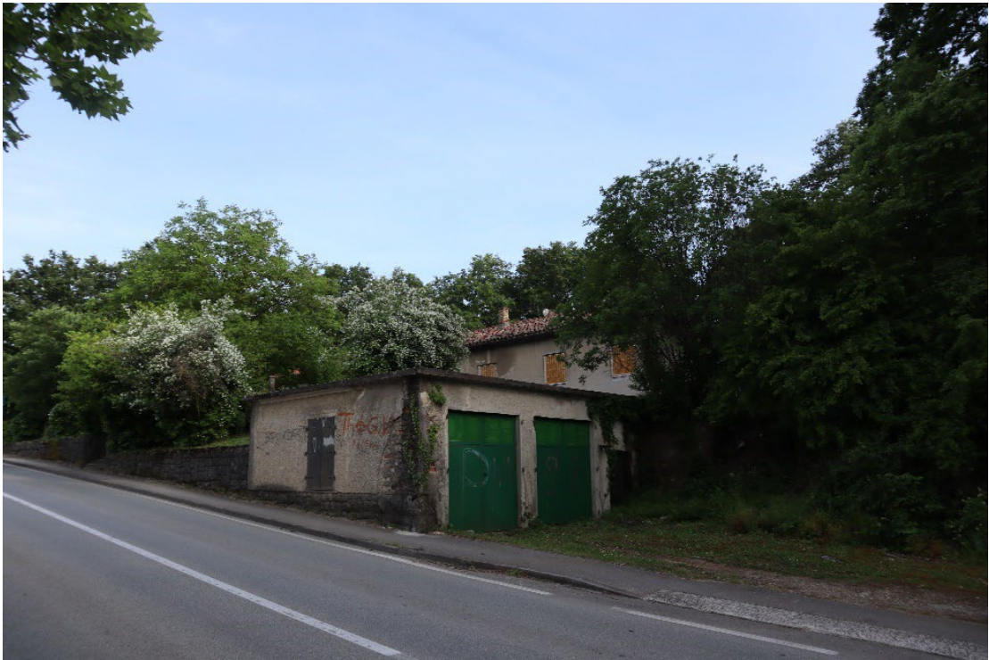
Slika 128 – Zgrada mjesnog ureda u Potpićnu (Autor: 3E PROJEKTI d.o.o.)
