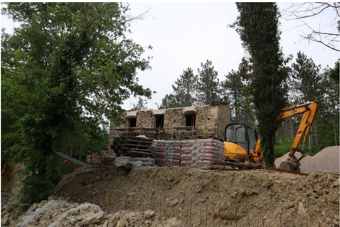
Slika 134 – Obnova tradicijske arhitekture i njezina revitalizacija (Autor: 3E PROJEKTI d.o.o.)
