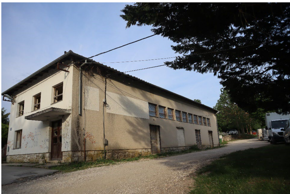
Slika 129 – Zgrada nekadašnjeg kina u Potpićnu (Autor: 3E PROJEKTI d.o.o.)
