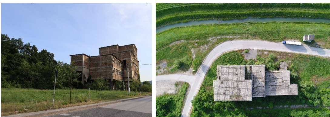
Slika 112 - Napušten prostor oko zgrade Separacije u Potpićanu (Autori: 3E PROJEKTI d.o.o. i Andlar)
