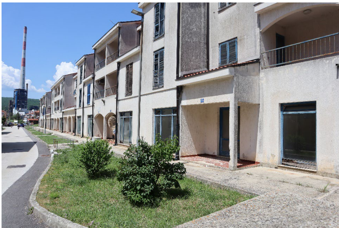
Slika 138 – Stambene zgrade HEP-a u Plomin Luci (Autor: 3E PROJEKTI d.o.o.)
