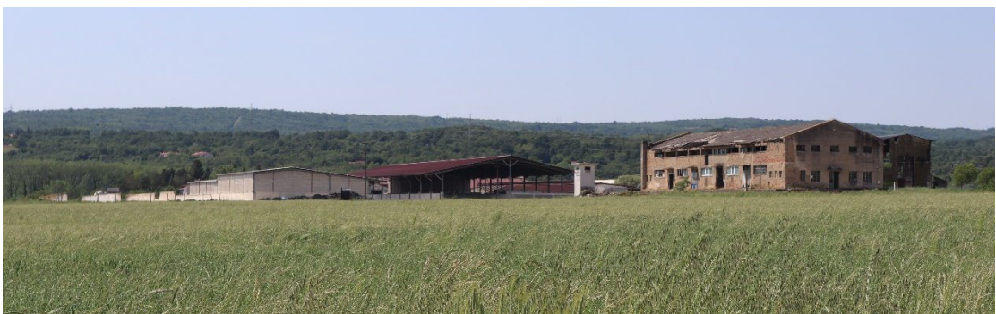
Slika 105 - Pogled na kompleks Bio Adria d.o.o. (Autor: 3E PROJEKTI d.o.o.)
