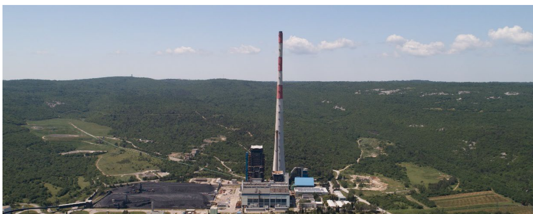
Slika 108 – Kompleks termoelektrane Plomin (Autori: 3E PROJEKTI d.o.o. i Andlar)
